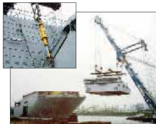
▲完美同步的平衡：使用恩派克液压同步提升系统将重达600多吨的军舰上层建筑放置到船体上。
